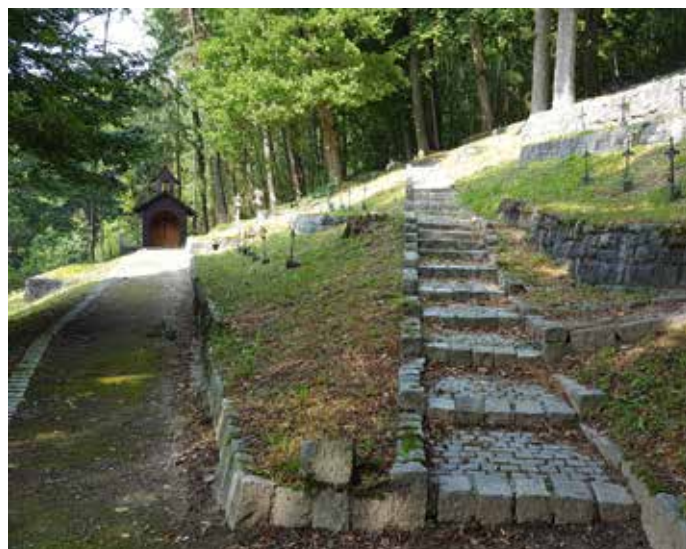
Der Waldfriedhof Urfahr vor der Generalsanierung
