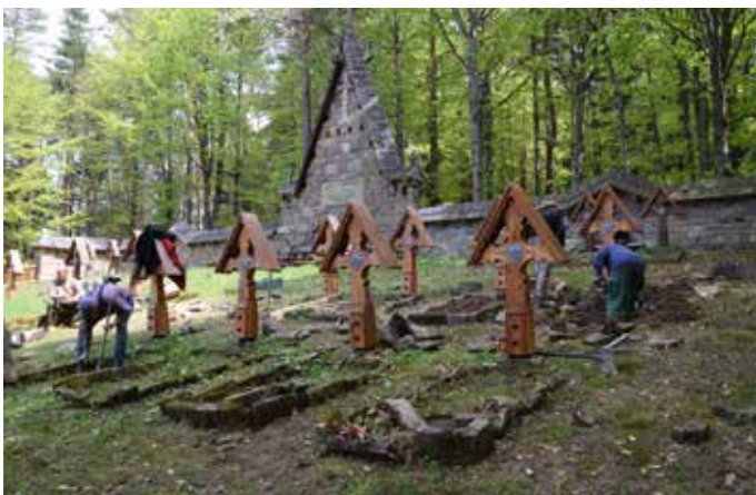
Erneuerung der Sandsteingrabeneinfassungen der Gräber 2022.
