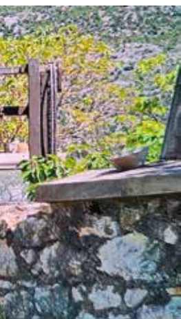
Auf der zuletzt wiedererrichteten Mauer wurde ein Kranz aufbetoniert.
